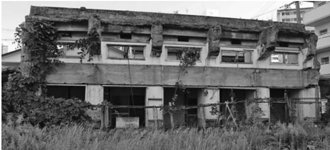
図 13 旧西野幼稚園遊戯室の南側のコンクリート壁
